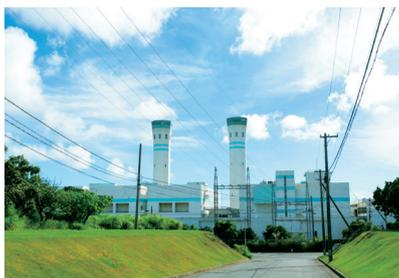
宮古第二発電所は沖縄電力が運営する内燃力発電所(火力発電所)。5基のディーゼル発電設備と3基のガスタービン発電設備により、宮古島と周辺の島々に電力を供給している。一方、近年宮古島では、太陽光や風力などの再エネの普及が飛躍的に拡大してきており、宮古第二発電所の役割が複雑化しているという。
